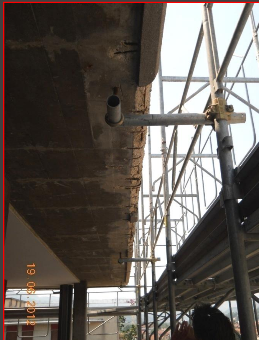
Fenomeni di spalling
